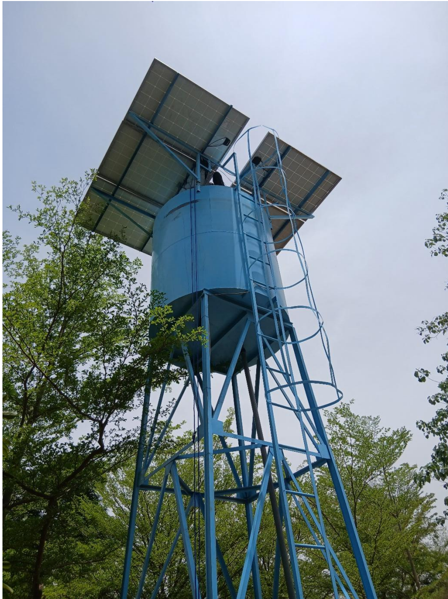
Vue du montage terminé
