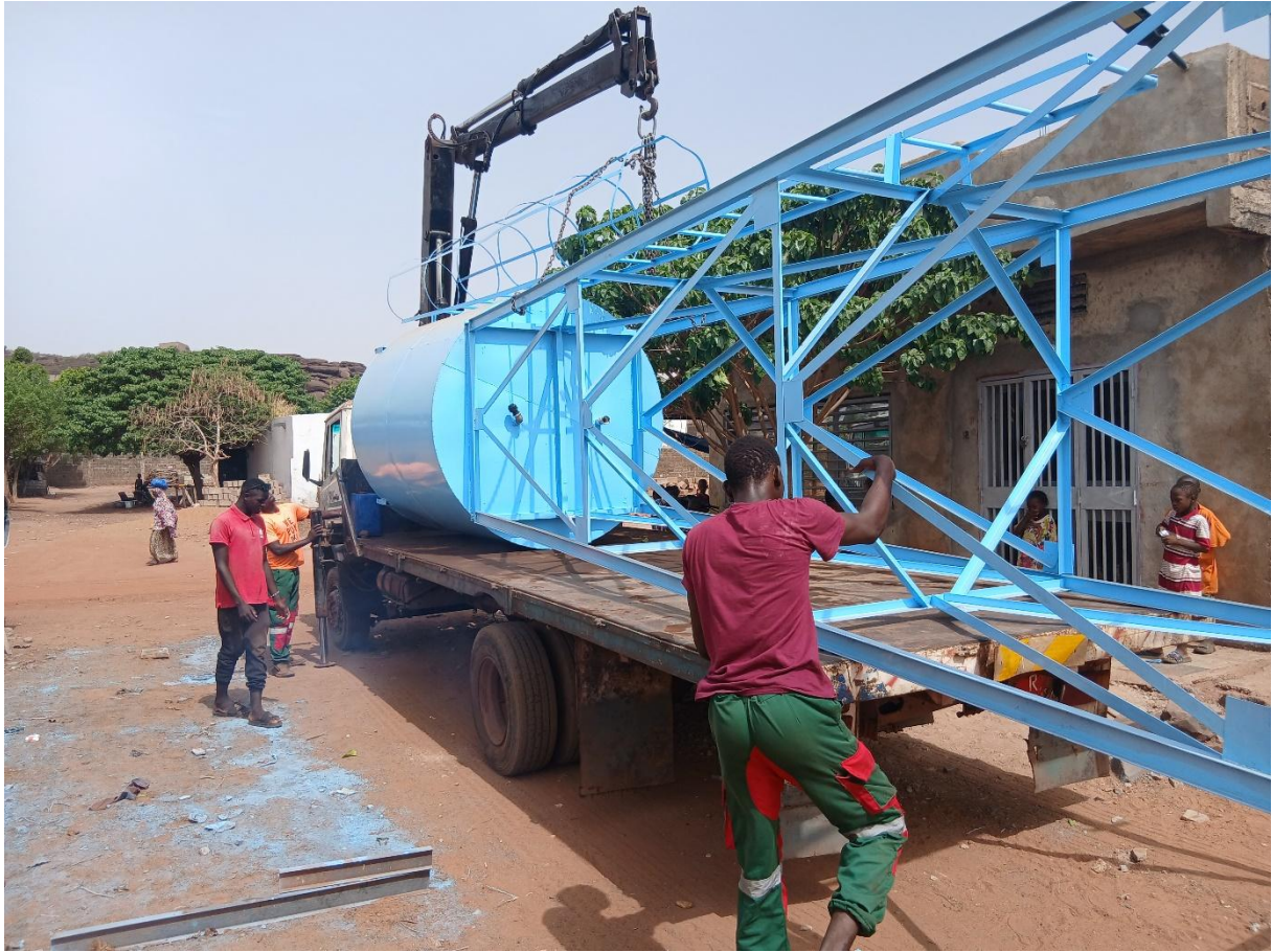
Finalisation des travaux de construction et l'acheminement sur le chantier
