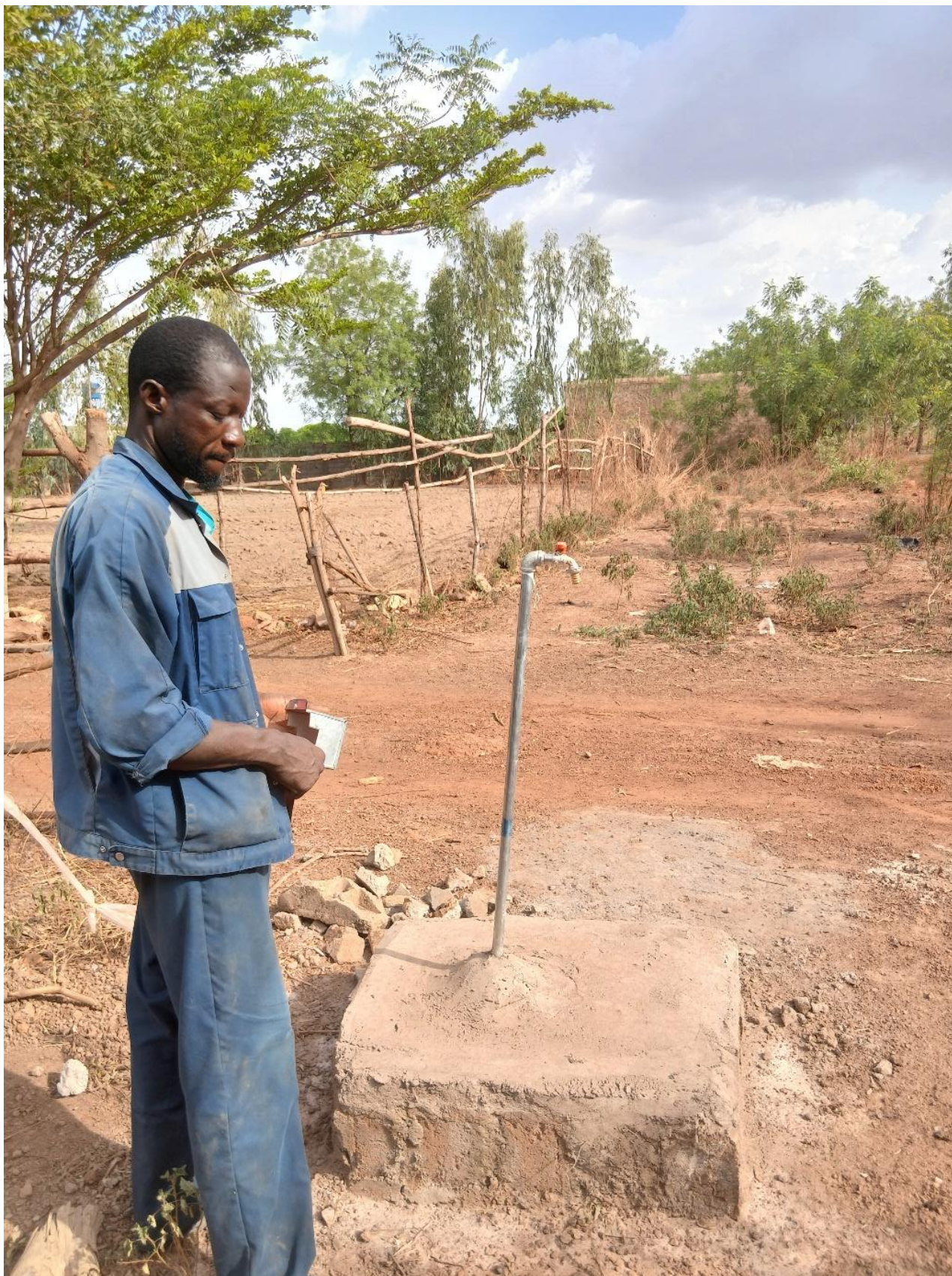
Installation du robinet témoin et d'offre de l'eau
