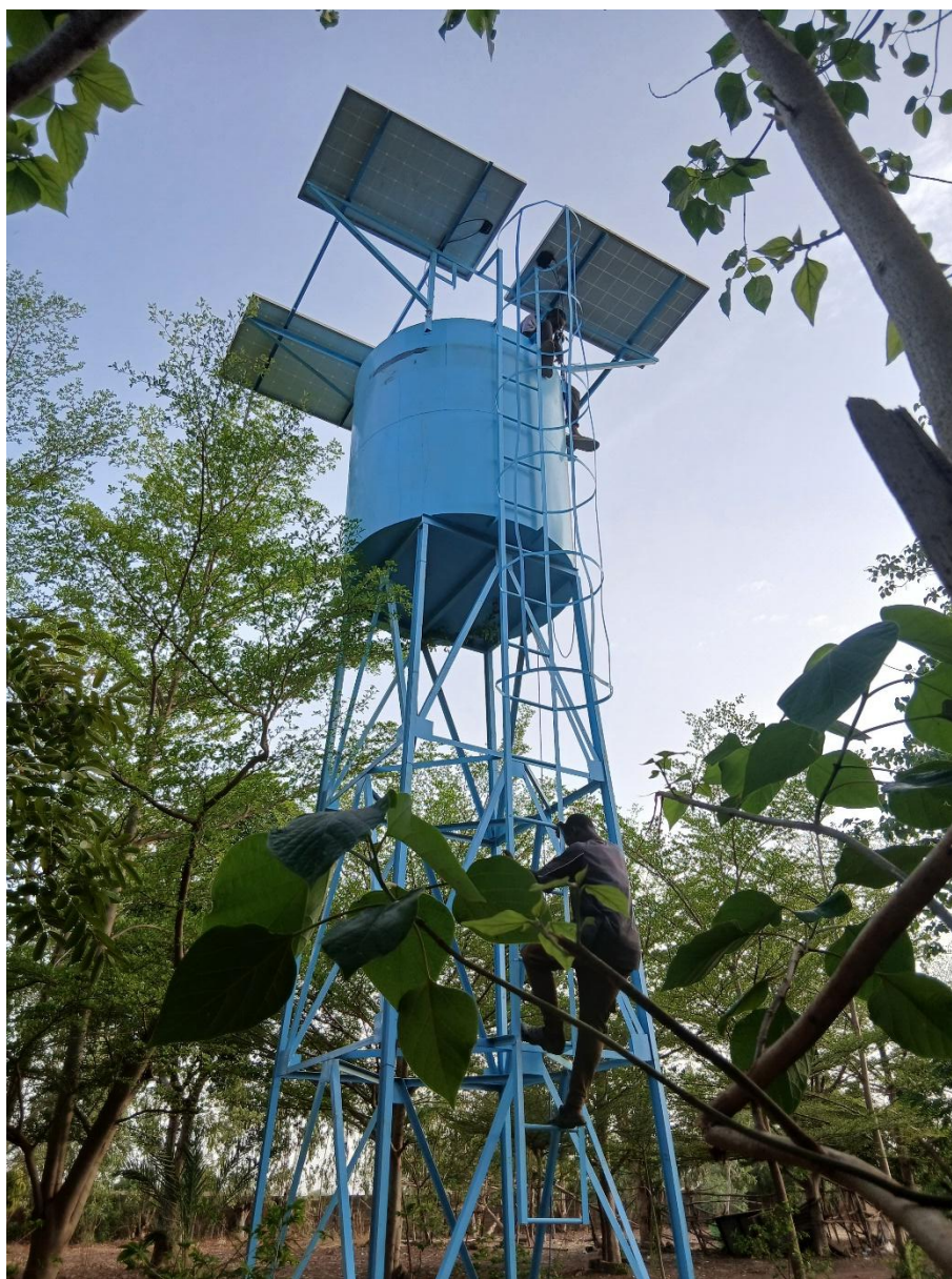
Vue de la montée des plaques solaires au-dessus du château
