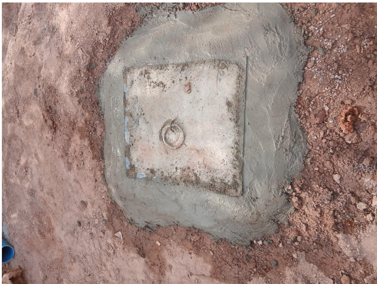
Vue de la tête de forage ferme et sécurisé
