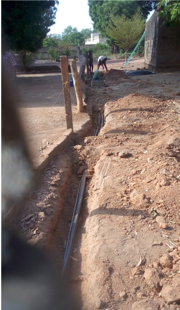
V) Travaux de pose des générateur d'énergie Photovoltaïque et support
