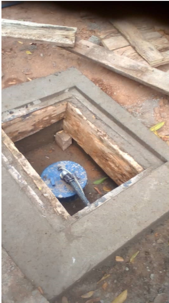
Vue de la tête de forage dans le regard ouvert
